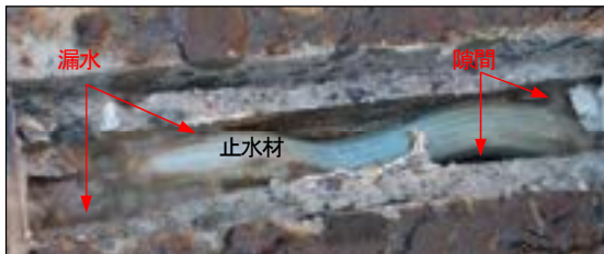
写真-2 内部の水膨張材の状況
