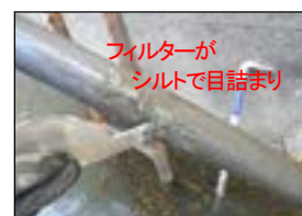
写真-20 内挿管の状態
