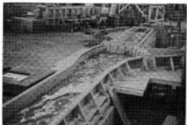
写真-6 分土工の水理模型実験の状況（計画最大通水量 16.7 \text{ m}^3/\text{sec} に相当する流量を流している。）
