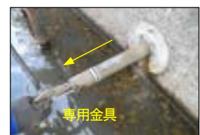
写真-21 内挿管引抜き
