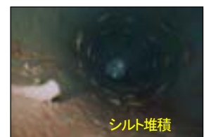
写真-19 内挿管内状況
