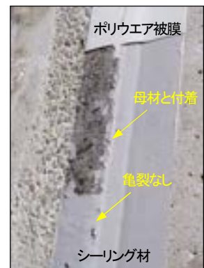
写真-8 シーリング表面
