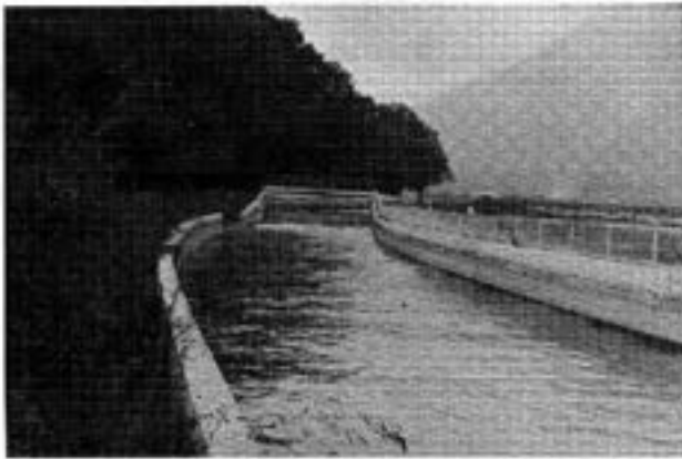
写真—2 水路内の流況，水路幅は8.0mである。
