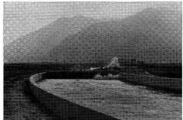
写真—3 波返しの無い消波工における流況，流れは右下の方に向かう。消波工の上に見えるのは角材などの詰材料を置いている。
