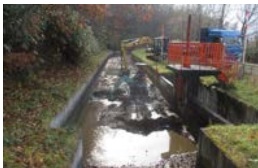
写真 7.6.1 堆積土砂の撤去作業状況
