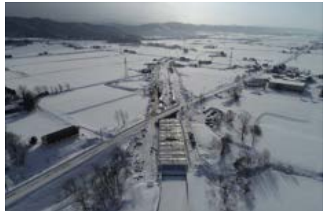
写真 9.3.4 冬期防寒養生（雪寒仮囲い工） （北海幹線用水路）
