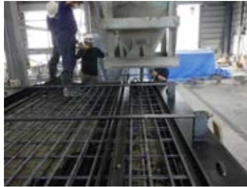
写真 3.1.2 コンクリート打設
