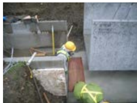
写真 9.1.40 簡易足場設置
