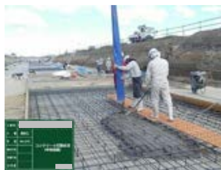
写真 9.1.9 底版コンクリートの締固め
