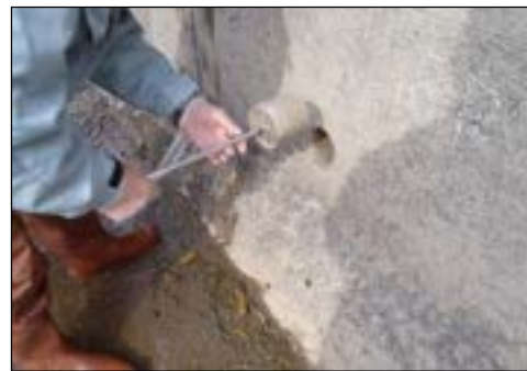
写真 3.9.12 弁きよの取り外し
