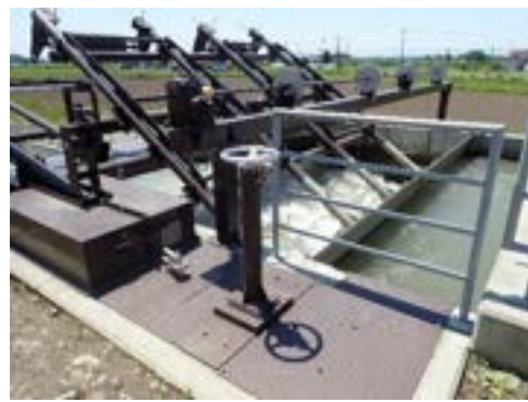
写真 6.2.9 小水力発電用分水工に併設
