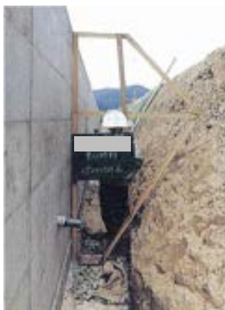
写真 3.8.3 裏込置換形状
