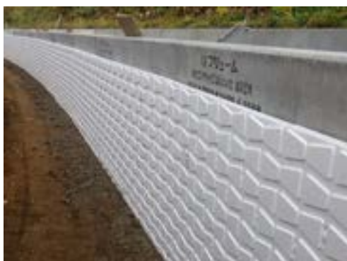
写真 3.8.8 空隙タイプの貼付
