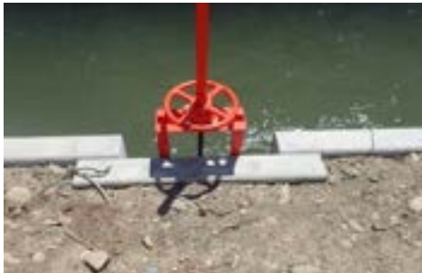
写真 5.4.6 鉄筋コンクリートスラブと外ネジ式ゲート
