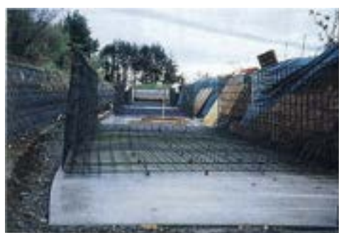
写真 3.7.3 均しコンクリート上の配筋状況
