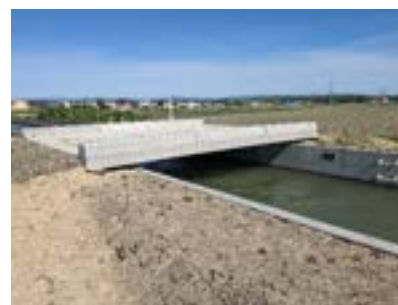
写真 8.3.3 簡易スラブ橋
