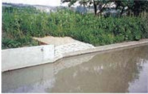
写真 6.2.14 改修と未改修区間の混在
