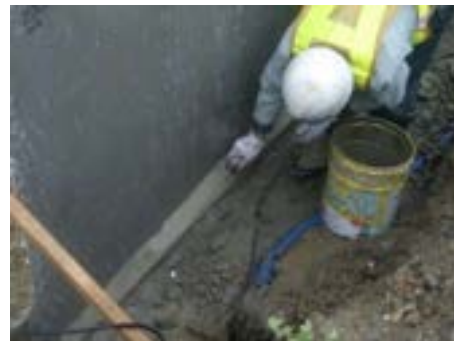
写真 9.1.44 流出防止モルタル打設
