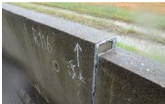
写真 3.4.3 10cm 浮上・段ズレ(前田幹線)
