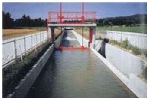
写真 6.2.16 バイパスの設置
