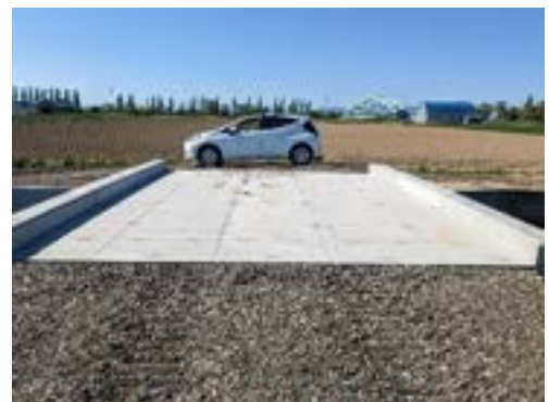
写真 8.3.4 二次製品ブロックによる地覆
