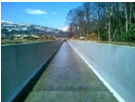
写真 9.1.45 幌加内幹線用水路
