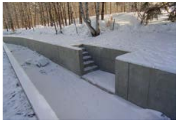
写真 7.3.11 工場製品大型雨水枡の半割タイプ (ステップは現場打ち鉄筋コンクリートによる)
