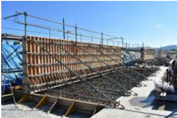
写真 9.3.3 L型擁壁型枠設置状況 （北海幹線用水路）
