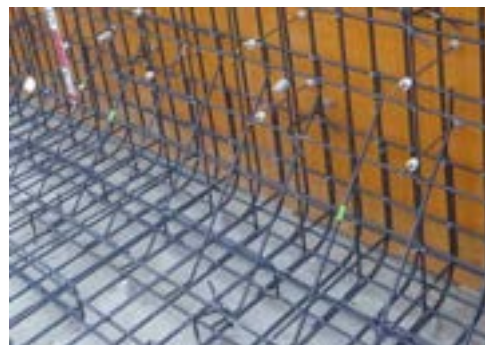
写真 3.5.2 ハンチ筋の固定方法
