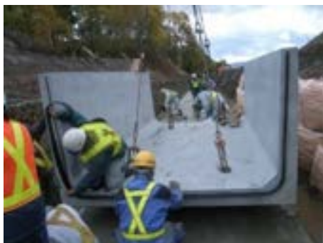
写真 9.1.39 ジョイントゴム取り付け
