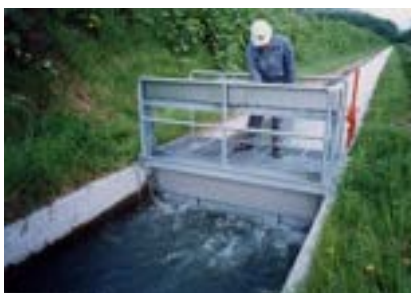
写真 6.2.4 巻上操作状況
