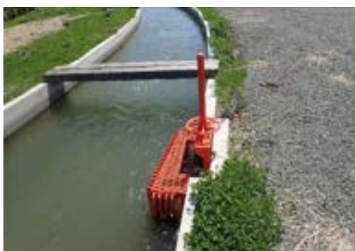
写真 5.4.8 スクリーンの設置例
