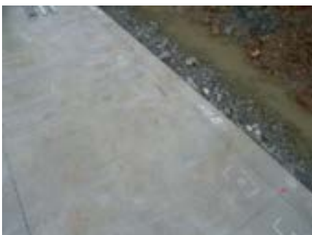
写真 9.1.28 墨出し、マーキング
