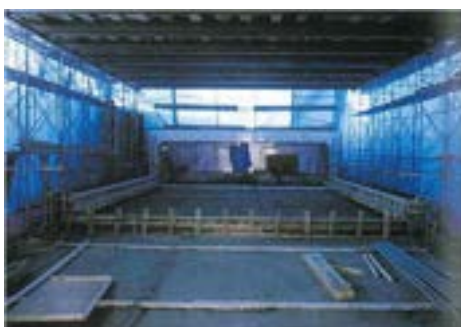
写真 9.1.17 雪寒仮囲い工の設置
