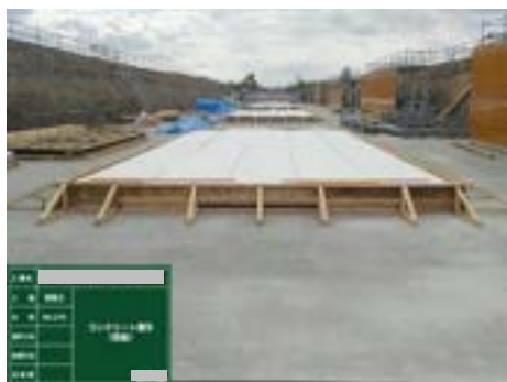
写真 9.1.15 養生用マットの設置
