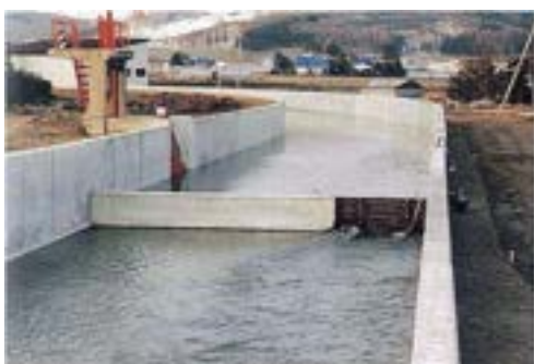
写真 6.2.10 正面越流型(左岸にあるのが補助ゲート)
