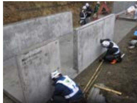
写真 9.1.36 敷モルタル突き固め
