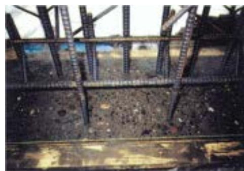
写真 9.1.13 レイタンスが除去された状況
