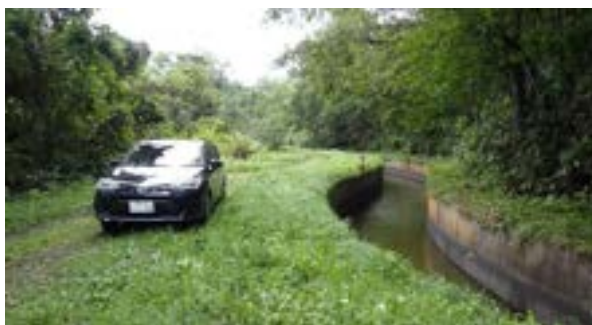
写真 3.10.5 山裾の狭い管理用通路
