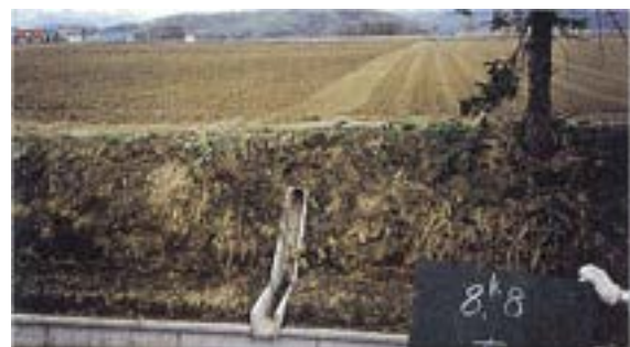
写真 7.2.3 ドレーンインレットの例
