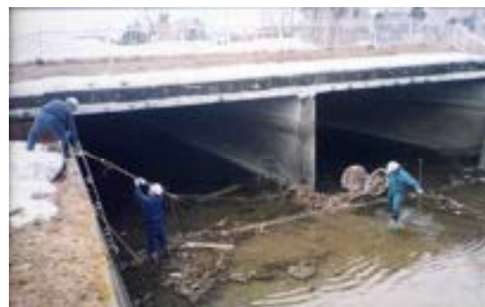
写真 7.6.2 大型ごみの撤去作業状況
