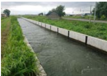
写真 3.6.10 くさび挿入方式(通水期)
