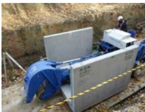
写真 3.1.10 自走式搬送機による布設
