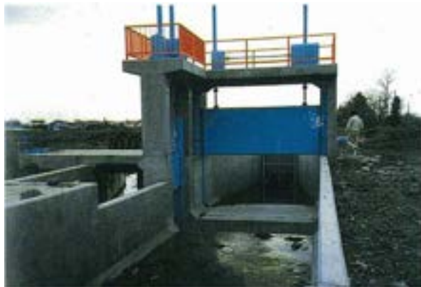
写真 6.3.1 チェックを併設した横越流余水吐
