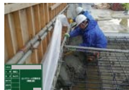
写真 9.1.7 ハンチ部の気泡抜き
