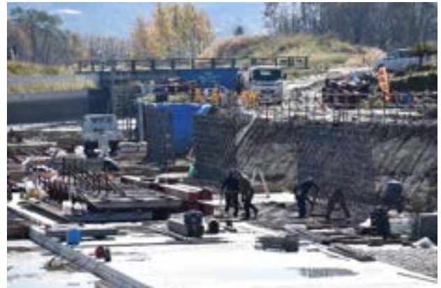
写真 9.3.2 L型擁壁鉄筋組立状況 （北海幹線用水路）
