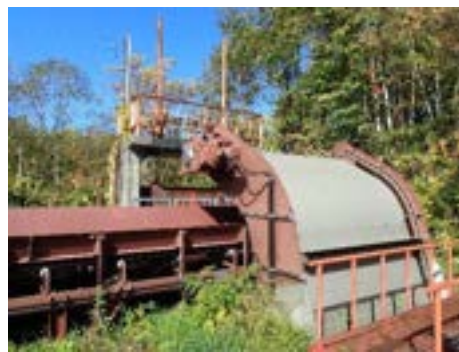
写真 7.5.4 全自動チェーン式スクリーン
