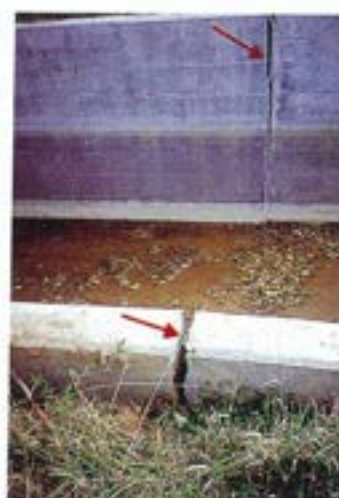
写真 3.4.6 目地の破損
