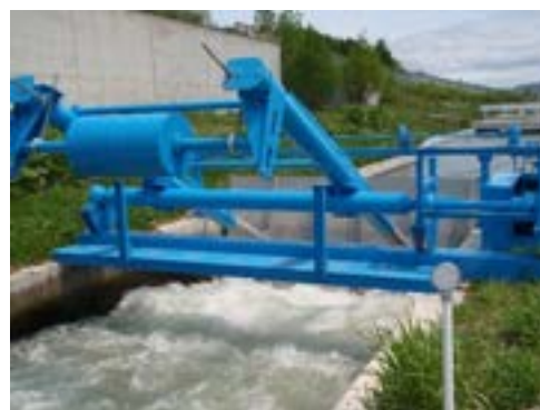
写真 6.2.7 自動ゲート下流側
