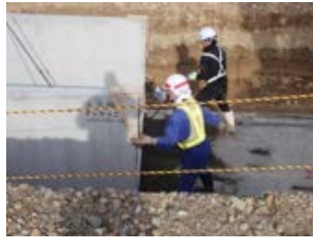
写真 9.1.42 バールによる微調整
