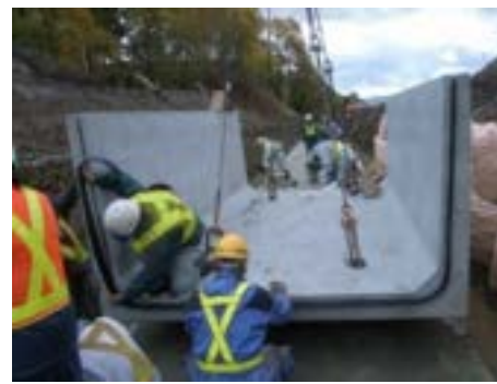
写真 3.6.6 ジョイントゴム取付
