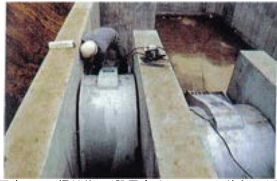
写真 6.3.8 据付状況(設置高は2~5cmの差をつける)
