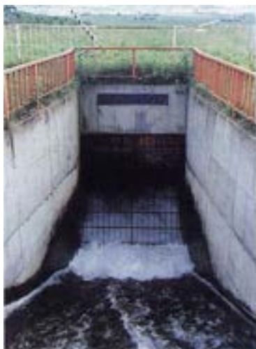
写真 8.2.1 サイホン入口の水位低下
