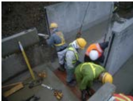
写真 9.1.37 充填材注入
