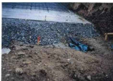
写真 3.7.1 基礎砂利と均しコンクリート
