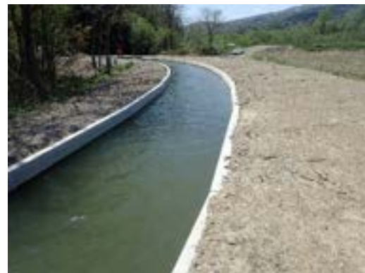
写真 3.6.12 曲線布設(長尺両斜切)
