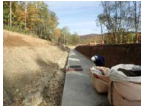
写真 9.1.26 均しコンクリート打設
