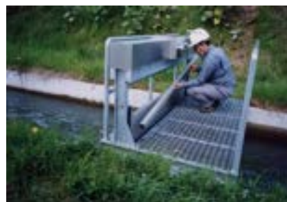
写真 6.2.5 堰板取付状況
