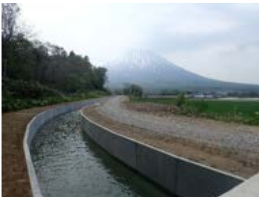
写真 3.6.11 曲線布設(短尺斜切)
