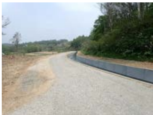
写真 3.10.3 左岸管理用道路と右岸通路
