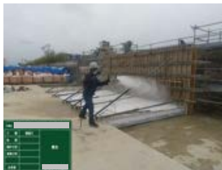
写真 9.1.16 散水養生状況
