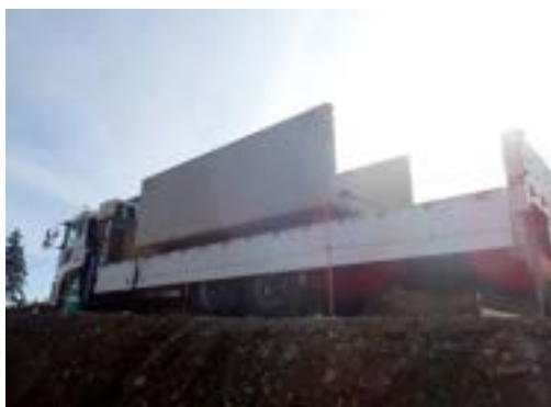
写真 3.1.7 トラック運搬(縦積み)
