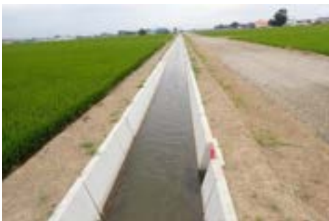
写真 4.1.1 V型トラフ水路
