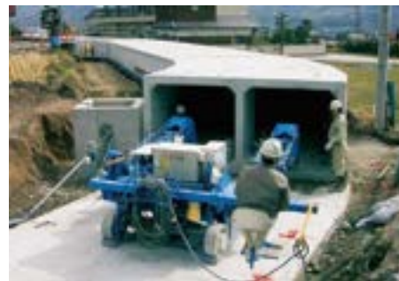
写真 9.1.22 自走式搬送工法 施工例
