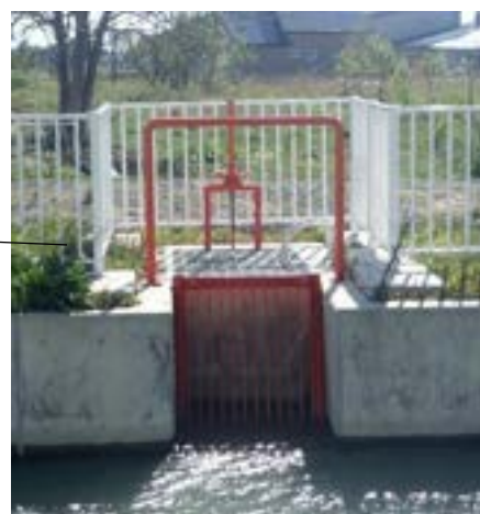
写真 5.4.1 操作式分水工施工例
