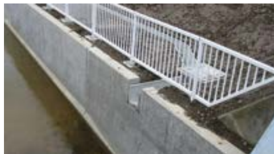
写真 7.2.4 バームインレットの例
