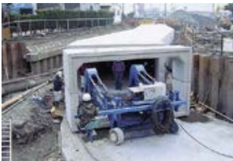
写真 9.1.21 自走式搬送工法 施工例
