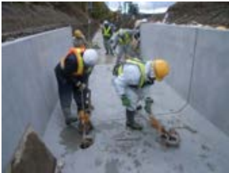
写真 9.1.41 レバーブロックによる引き込み
