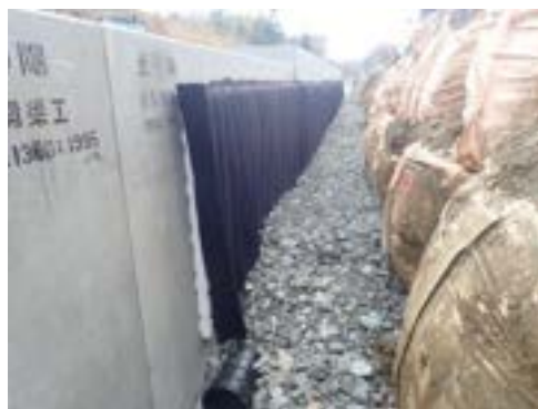
写真 3.8.9 フィルター材の設置
