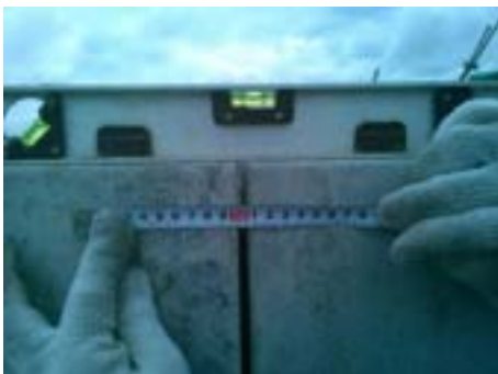
写真 9.1.43 目地間隔確認
