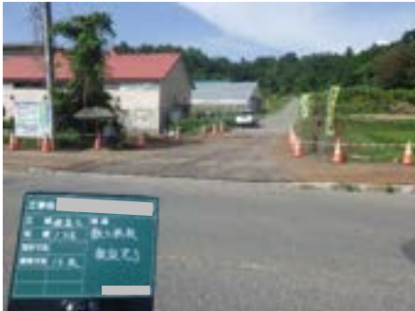
写真 9.1.19 敷鉄板の布設
