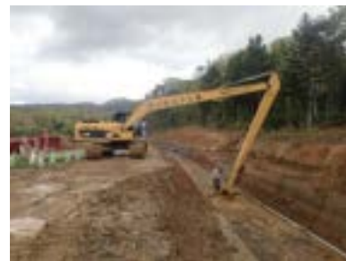
写真 3.10.2 床掘法面
