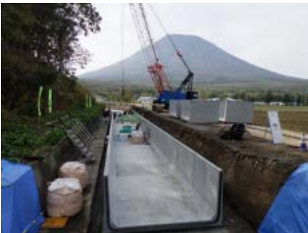
写真 9.3.5 プレキャストコンクリート水路設置状況 （倶知安幹線用水路 L=2.4m）
