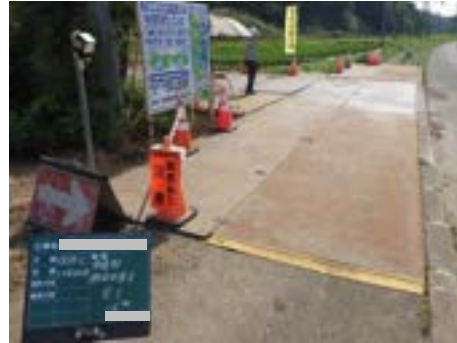
写真 9.1.20 歩道部の養生
