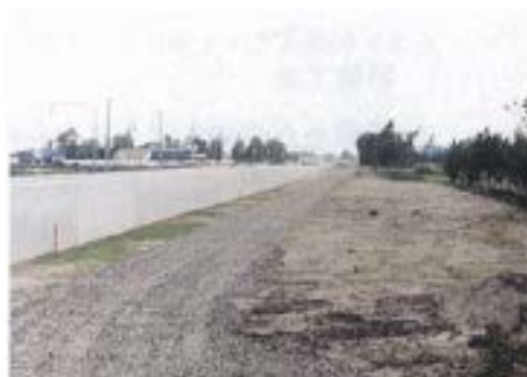
写真 3.8.11 置樋装工の例
