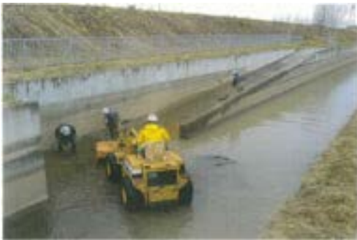
写真 7.6.3 土砂搬出作業状況 (ホイールローダ 0.3m 3 )
