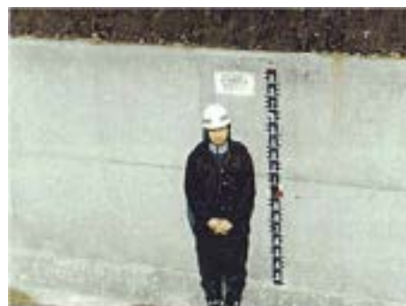
写真 7.4.3 量水標・距離表示板の設置例
