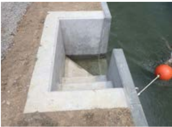
写真 7.3.10 現場打ち L 型擁壁タイプ
