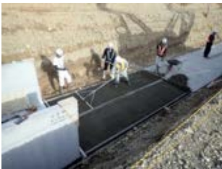
写真 9.1.32 敷モルタル敷均し
