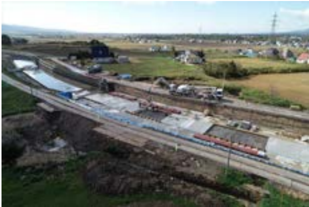
写真 9.3.1 床版コンクリートの打設状況 （北海幹線用水路）
