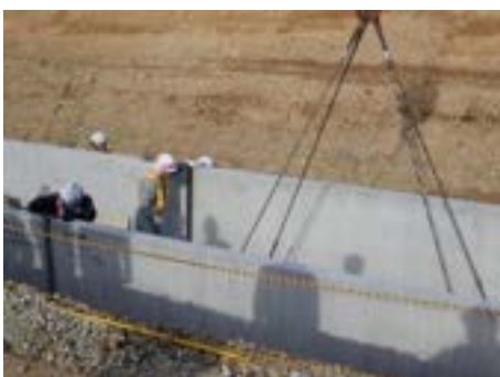
写真 9.1.34 水路の仮設置
