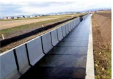
写真 3.6.9 くさび挿入方式(落水期)
