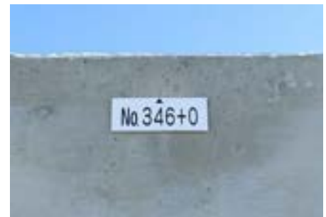
写真 7.4.1 距離表示板の設置例
