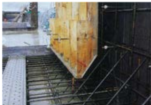
写真 3.5.1 ハンチ内側鉄筋の配置
