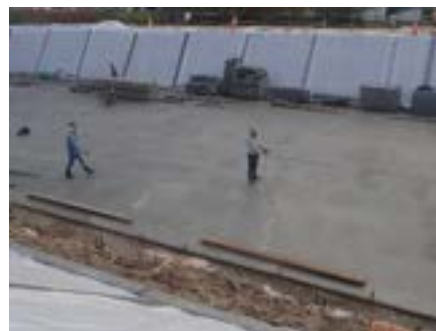
写真 3.7.2 水路センターの墨出し
