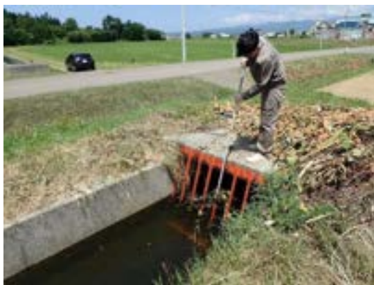
写真 7.5.1 草葉類の除去作業状況
