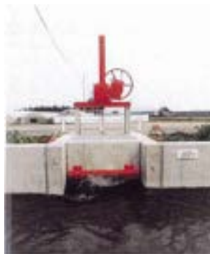
写真 5.4.3 脱着式スクリーン
