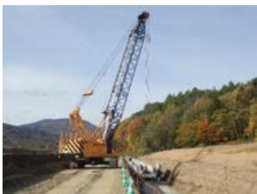
写真 3.1.9 クローラクレーンによる布設
