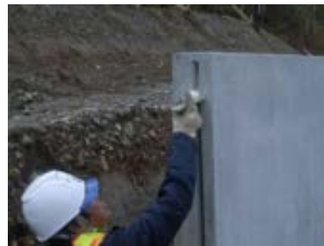
写真 9.1.38 専用治具による充填量の確認
