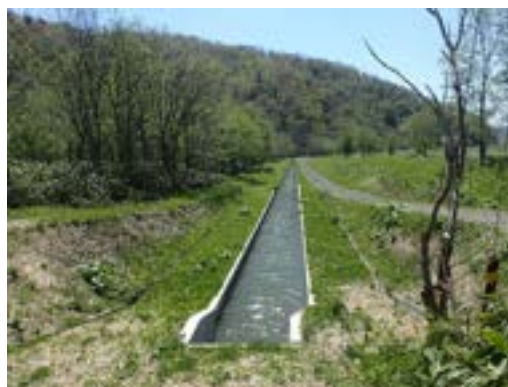
写真 3.10.4 右岸管理用道路と左岸通路
