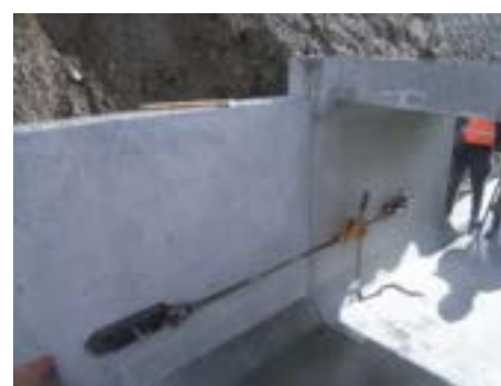
写真 3.6.8 ボックス引き込み状況
