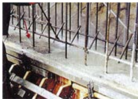
写真 9.1.12 エッチング状況 （赤矢印の先がエッチング済み）
