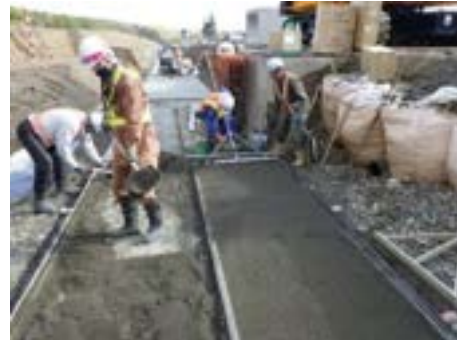
写真 9.1.31 敷モルタル撒出し
