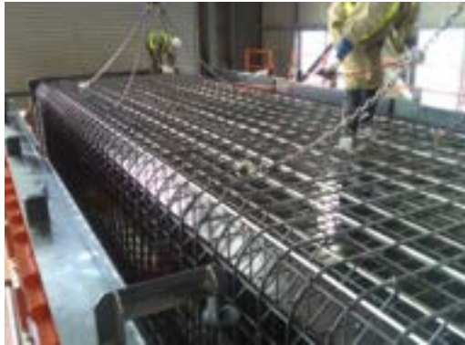
写真 3.1.1 型枠・鉄筋の設置
