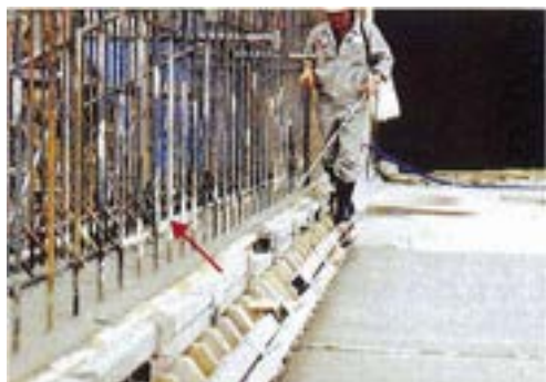
写真 9.1.11 遅延剤の散布状況 (赤矢印の先が鉄筋に付着したノロ)
