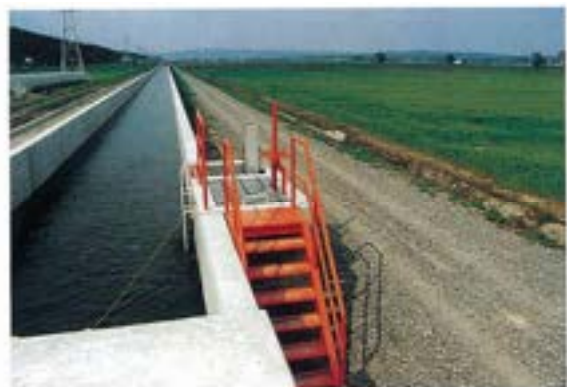
写真 1.1.2 当別幹線用水路
