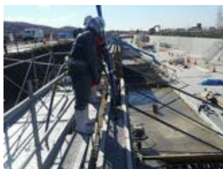
写真 9.1.8 側壁コンクリートの締固め
