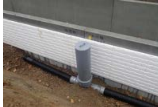
写真 3.8.5 発泡ポリスチレンの設置状況
