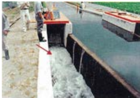
写真 6.3.11 越流型余水吐の併設
