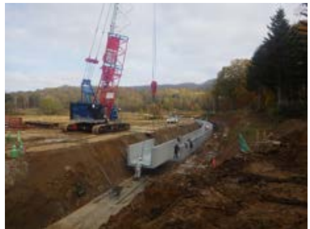
写真 9.3.6 プレキャストコンクリート水路設置状況 （幌加内幹線用水路 L=5.0m）
