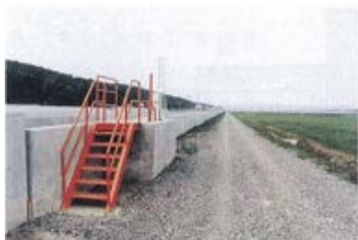
写真 3.8.10 置樋装工の例
