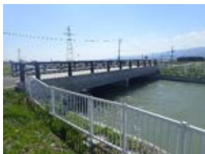
写真 8.3.1 現場打ち鉄筋コンクリート
