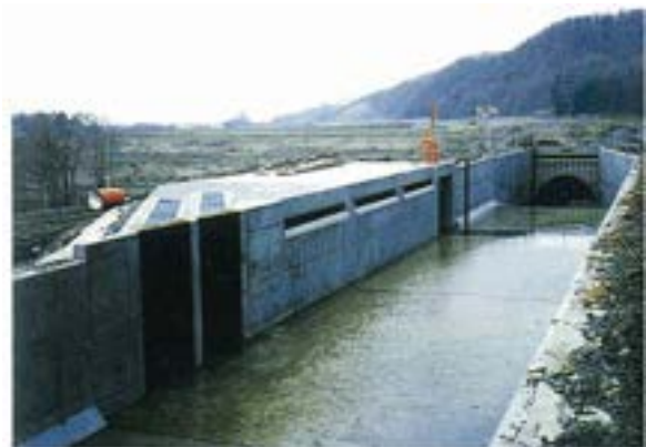
写真 6.3.2 サイホン余水吐を併設した横越流余水吐
