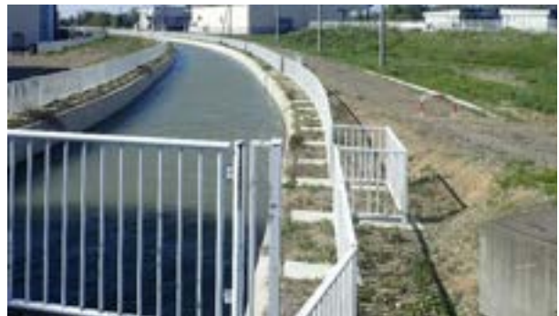
写真 7.3.1 基礎ブロックの横長配置例
