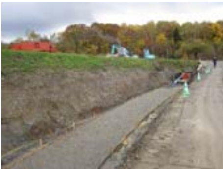
写真 9.1.25 基礎砂利敷均し
