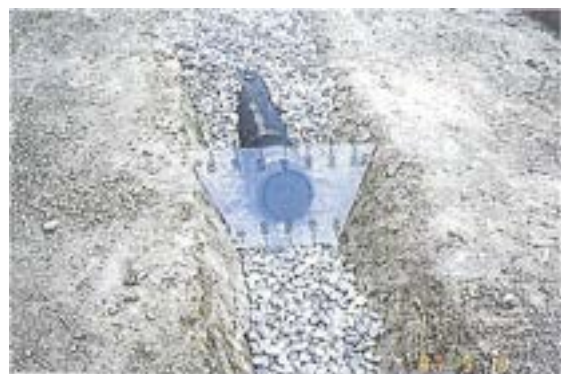
写真 3.9.2 アンダードレーン方式
