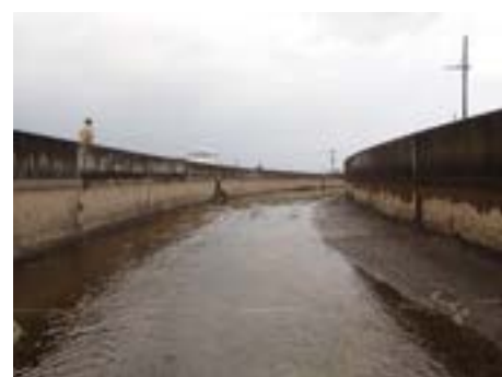
写真 3.4.4 20cm 浮上・傾倒(空知幹線)
