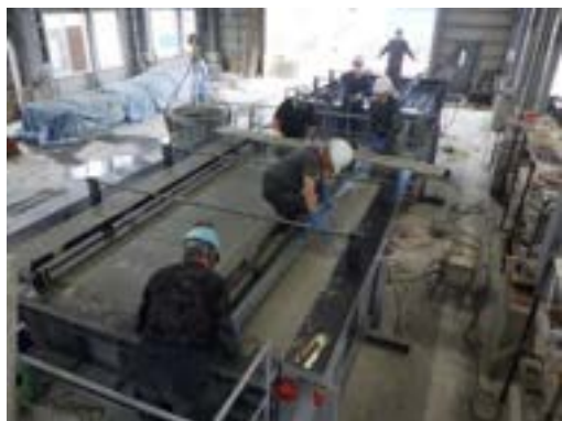
写真 3.1.3 打設面(底板下面)のコテ仕上げ
